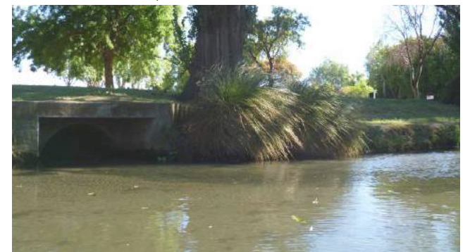
Stormwater outlet, Cambridge Terrace Ōtākaro / Avon River
